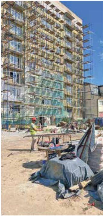
— Это девятиэтажка на два подъезда, в которой 64 квартиры: 32 двухкомнатные и 32 трехкомнатные. Строительство дома началось в 1987 году, затянулось на долгие годы, а в 1998 году его полностью забросили. За эти годы здание без обслуживания начало рушиться и разваливаться. Несущие стены верхних этажей рассыпались процентов на 60, кровля протекала вся, момент обрушения плит перекрытия был очень большим. Также произошло разрушение перегородок балконов, межкомнатных перегородок. Подвал оказался
